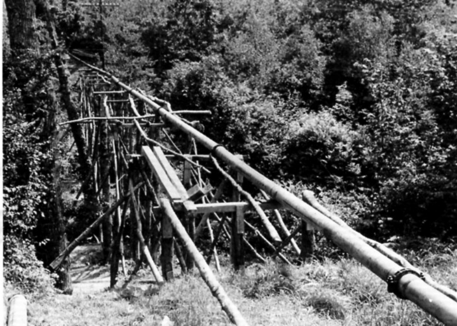
ノルマンディ付近に敷設された陸上送油パイプ。この写真のように、地形の凹凸に合わせて足場を組むなどして多数のパイプが敷設された。送油ステーションから出されたパイプは、次の中継ステーションへ、また大小の給油施設へと木の枝のように伸びていった。
