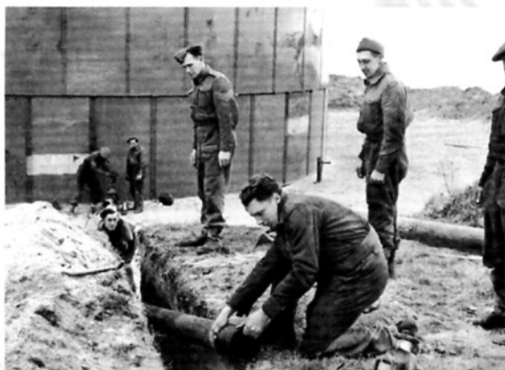
フランス国内の送油中継ステーションのタンクに陸上送油用のパイプを接続し、埋設しているイギリス工兵。連合軍の進撃を追うように、送油パイプは延びていった。
