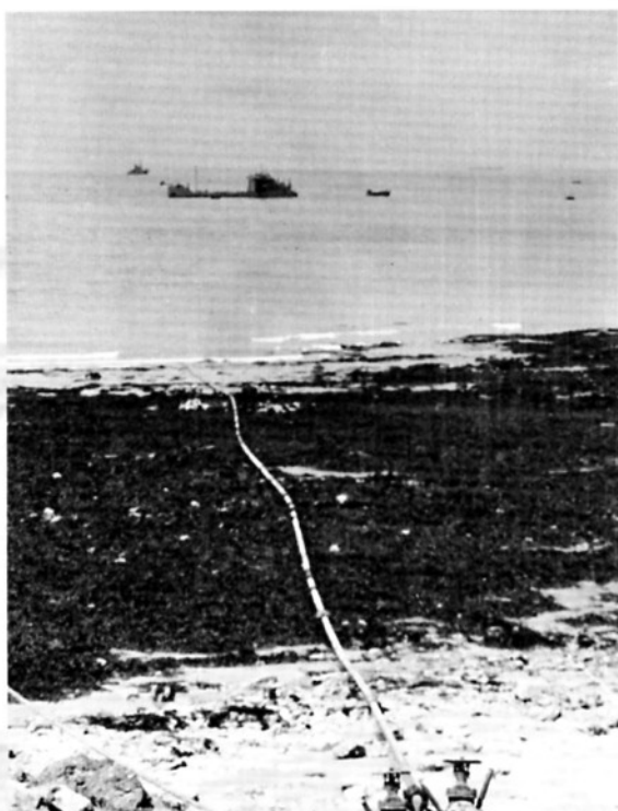
ノルマンディ上陸作戦初期には、沖合1.6〜3キロに停泊するタンカーから直接パイプを出して海岸まで敷設し、燃料を送った。写真には海岸に引き上げられたパイプが伸びており、手前には備蓄タンクのものと思われるバルブも見えている。
