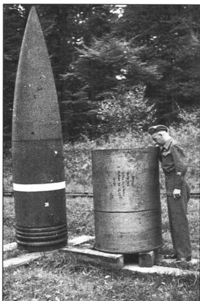
(左上) 80 cm列車砲ドーラの対コンクリート弾で、セバストポリ要塞攻撃でも使用されている。重量は7.1tもあり、砲弾の高さは240 cmで右の薬莖部は高さ130 cmである。また、榴弾(HE)の場合は4.8tで射程は47 kmだった。
