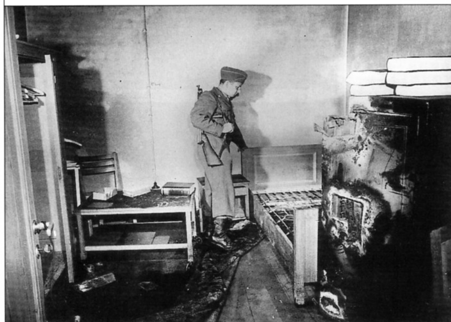
地下壕のヒトラーの寝室だが、証拠書類を捜すため巨大な金庫がバーナーで焼き切られている。壁の向側はヒトラーの居室で、さらに奥は浴室になっていた。
