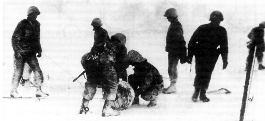
厳寒の中、ドイツ軍歩兵の前進を妨害するために有利鉄線を敷設するアメリカ軍工兵部隊。ドイツ兵が有利鉄線を切断したときに爆発するよう、爆薬を取り付けることも行われた。こうした工兵部隊の地道な活動が、ドイツ軍の前進を大きく阻むこととなった。
