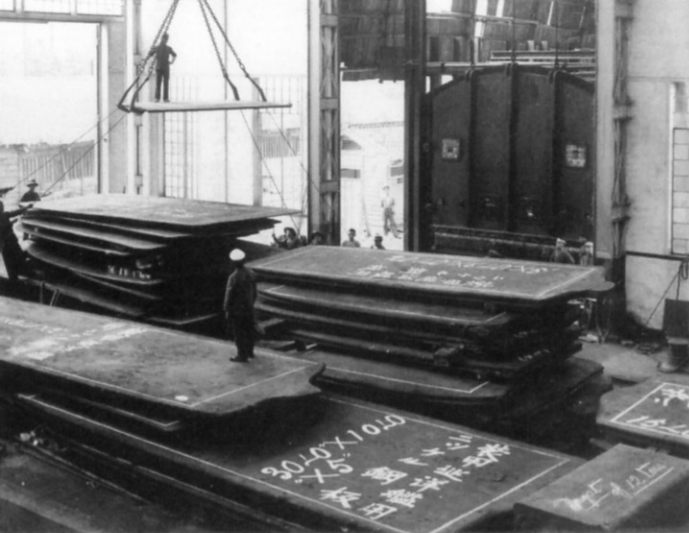
戦時中の日本では、船体用鋼材の輸入をロシア側に妨害されるのを防ぐため、中立国アメリカへ発注するなど苦心が必要だった。また、特殊な処理の必要な甲鉄の開発に挑戦し、苦闘の末成功させた。写真は『筑波』用ニッケル鋼板（明治38年7月2日撮影）。
