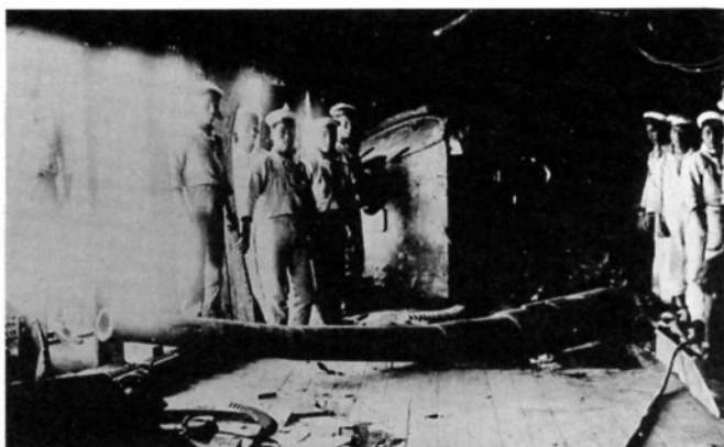
黄海海戦時、被弾により砲身が「く」の字状に変形した松島の12センチ砲。
