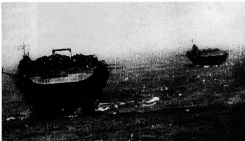
うねりに艦首を沈める空母加賀(手前)と瑞鶴。昭和16年、真珠湾攻撃に向かう艦影で、このような厳しい海象下での高速航行は、船型の小さい随伴駆逐艦の航続力を著しく低下させた。
